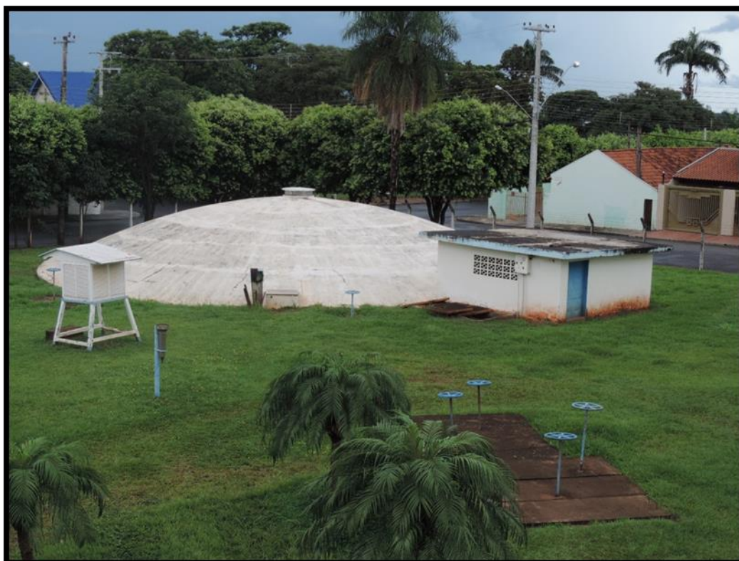
Imagem 20 – Reservatório Semienterrado – ETA
