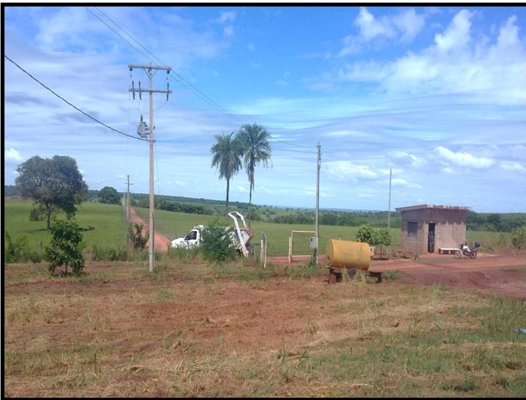
Imagem 93 – Entrada da Área de Disposição e Usina de Britagem/Reciclagem de RCC
