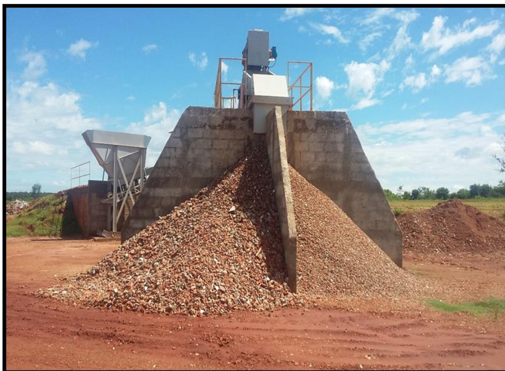
Imagem 97 – Produtos pós processamento do RCC na Usina de Britagem/Reciclagem
