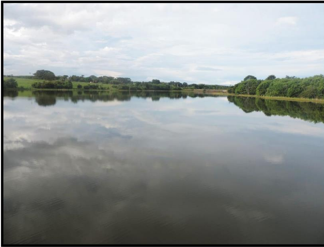
Imagem 17 – Captação superficial no Córrego da Cabeceira Comprida
