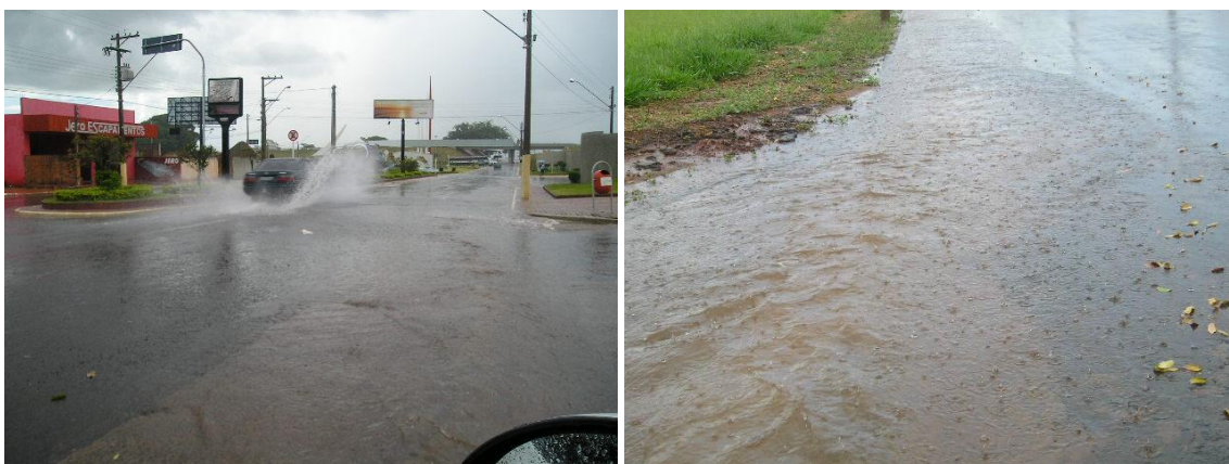
Imagem 55 – Acúmulo de águas superficiais na av. Navarro de Andrade e Jardim Europa – Ponto crítico 4 (SOLUCIONADO)
