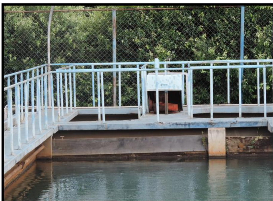
Imagem 25 – Floclador mecânico
