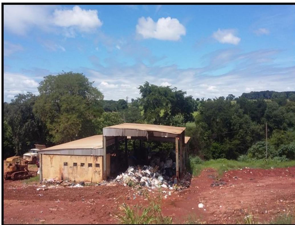
Imagem 77 – Centro de Triagem de Resíduos Recicláveis no Aterro Sanitário
