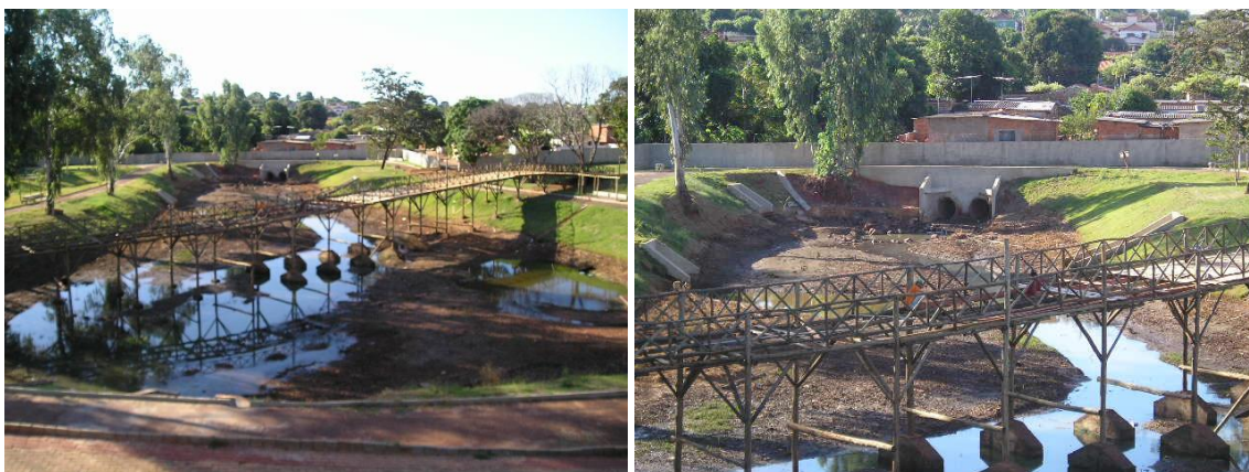
Imagem 48 – Obras de retenção de águas pluviais em execução na vila Maria/FEPASA
