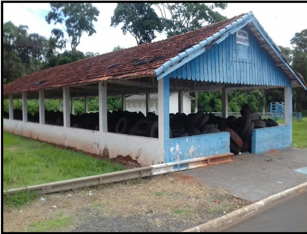
Imagem 115 – Barracão onde são armazenados os pneumáticos
