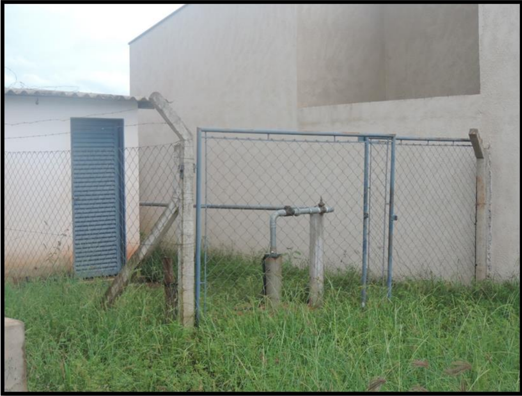
Imagem 9 – Poço Alto Bela Vista
