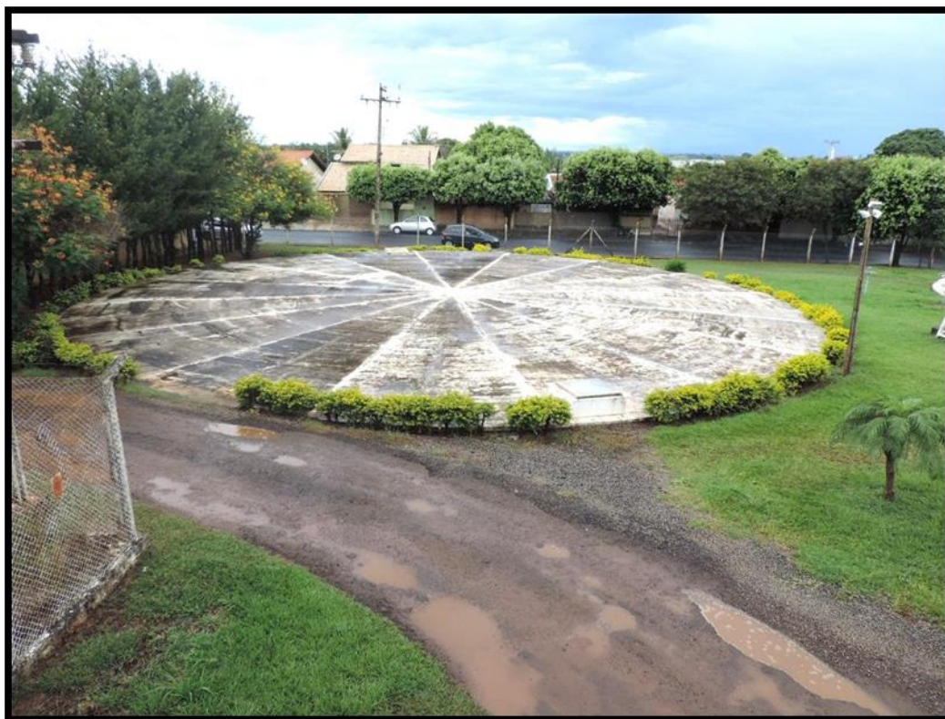
Imagem 19 – Reservatório Alimentador Enterrado – ETA
