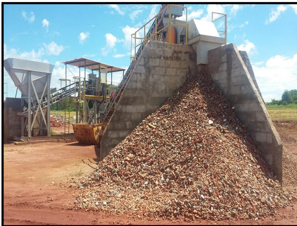
Imagem 94 – Usina de Britagem/Reciclagem de RCC
