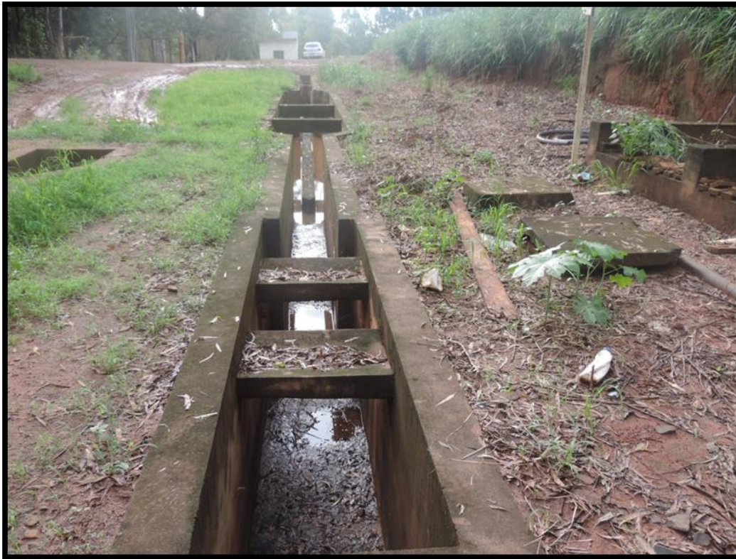
Imagem 42 – Caixa de areia em construção
