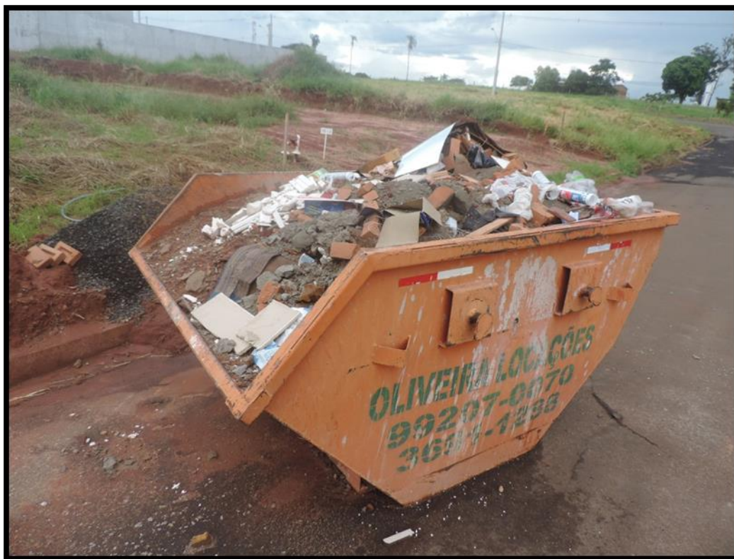
Imagem 88 – Caçamba de RCC
