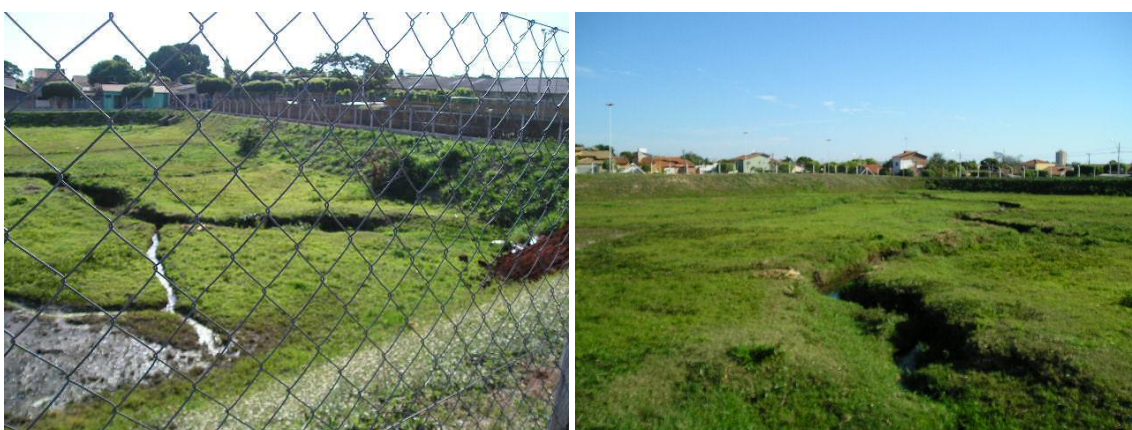
Imagem 51 – Obra de retenção de águas pluviais (piscinão) no Jardim Morumbi.
