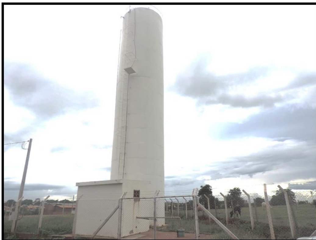
Imagem 14 – Reservatório Vila Lobos
