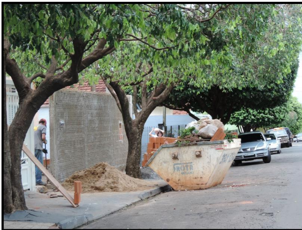
Imagem 91 – Caçamba de RCC
