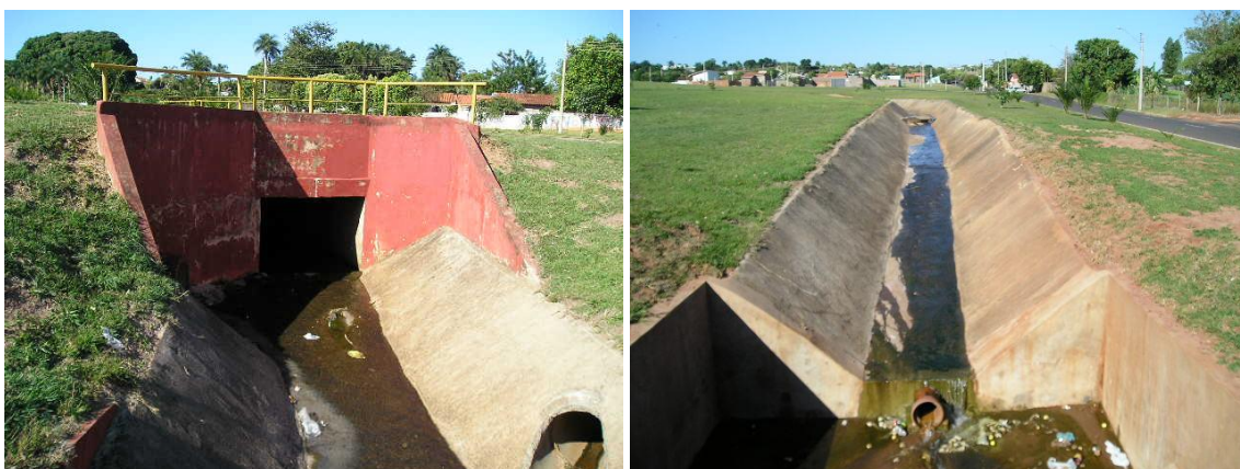
Imagem 49 – Início do canal, a céu aberto, com proteção lateral, no Córrego Mangará
