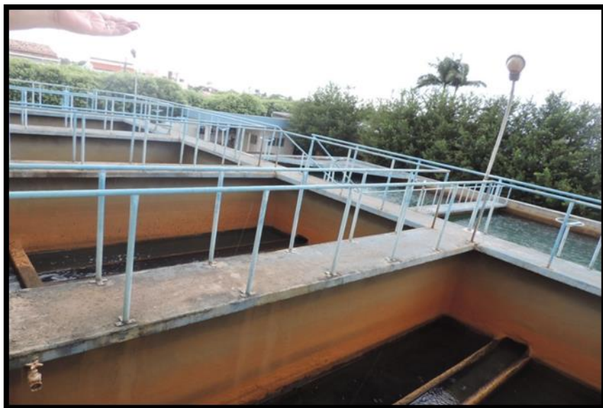
Imagem 28 – Tanque de filtração
