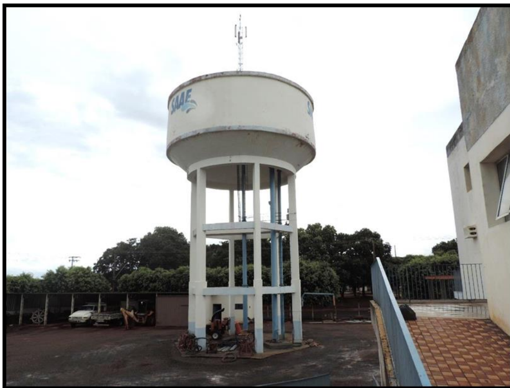
Imagem 22 – Reservatório Elevado – ETA
