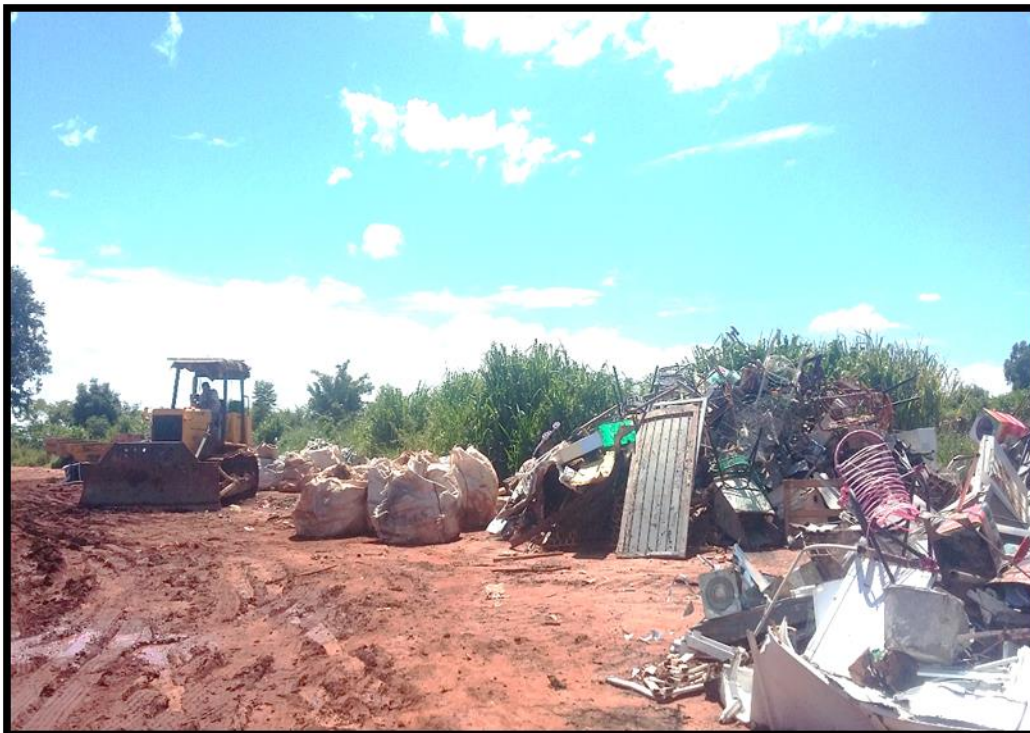
Imagem 98 – Triagem de RCC e Volumosos na Usina de Britagem/Reciclagem
